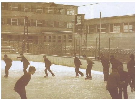
Zdjęcie 272. Łaziskie lodowisko w latach 70. W tle budynek ZSG.
