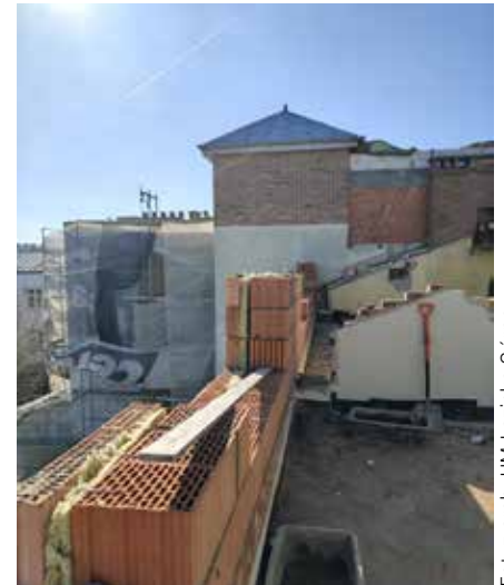
Dzięki rozbudowie w SP6 powstają dodatkowe klasy
