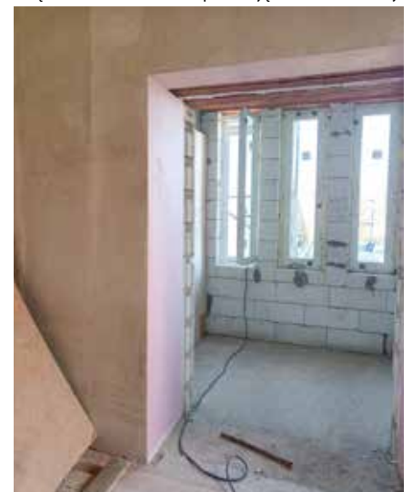
W segmentach A i B trwają prace wykończeniowe
