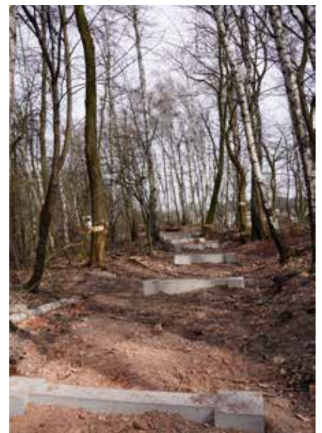
Fundamenty pod pomost są już gotowe
