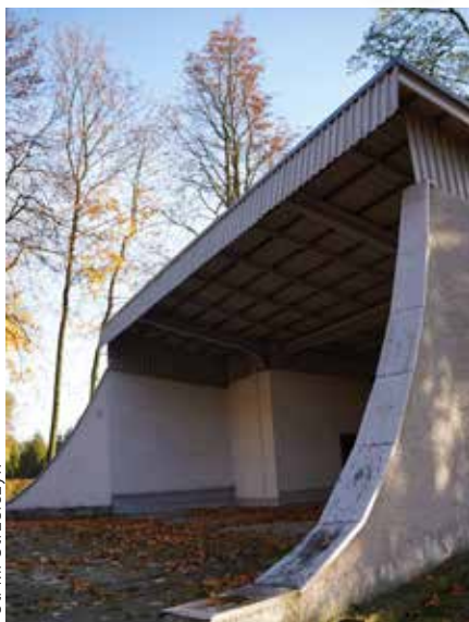
Budynek amfiteatru zostanie zmodernizowany
