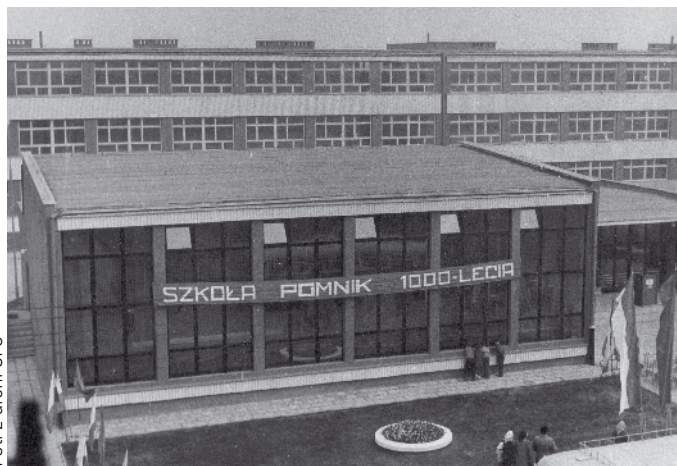
Budowa tysiąclatki przypada na lata 1960–1965
