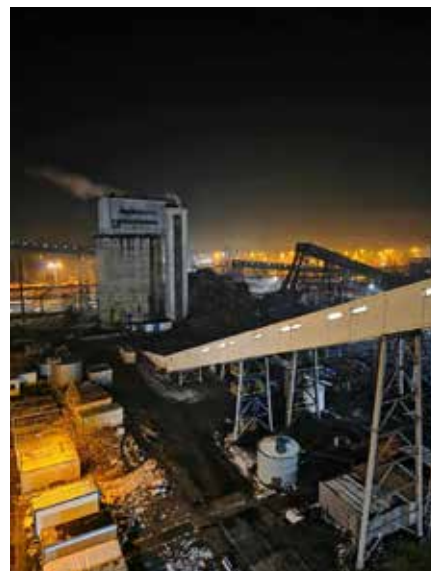
Pomosty taśmowe i zbiornik na węgiel uległy zawaleniu
