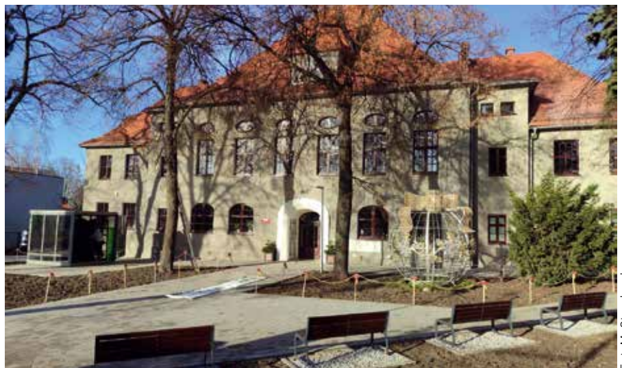
Zmodernizowana przestrzeń przed Miejską Biblioteką Publiczną w Łaziskach Górnych
