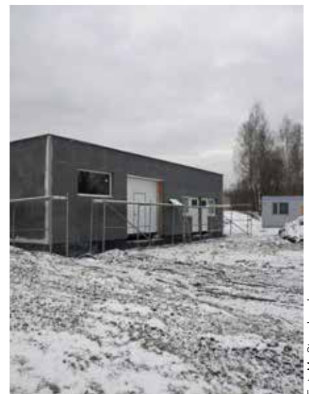
Przy boisku głównym powstaje budynek zaplecza
