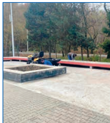
Prace przedłużyły się z powodu intensywnych opadów
