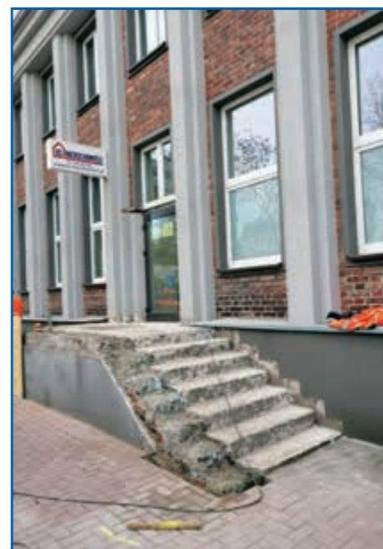
Budowa podjazdu rozpoczęła się pod koniec października
