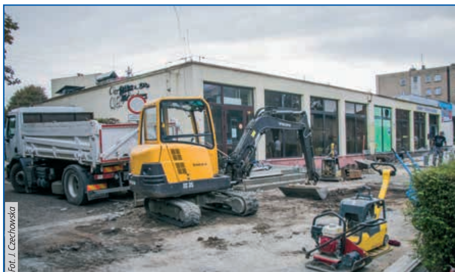
Przed budynkiem przy ul. Dworcowej trwa remont nawierzchni
