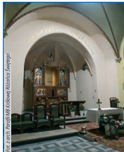
Prace remontowe w kościele w Łaziskach Górnych postępują
