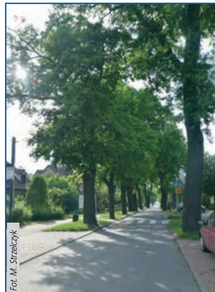
W przyszłym roku czeka nas przebudowa ul. Chopina
