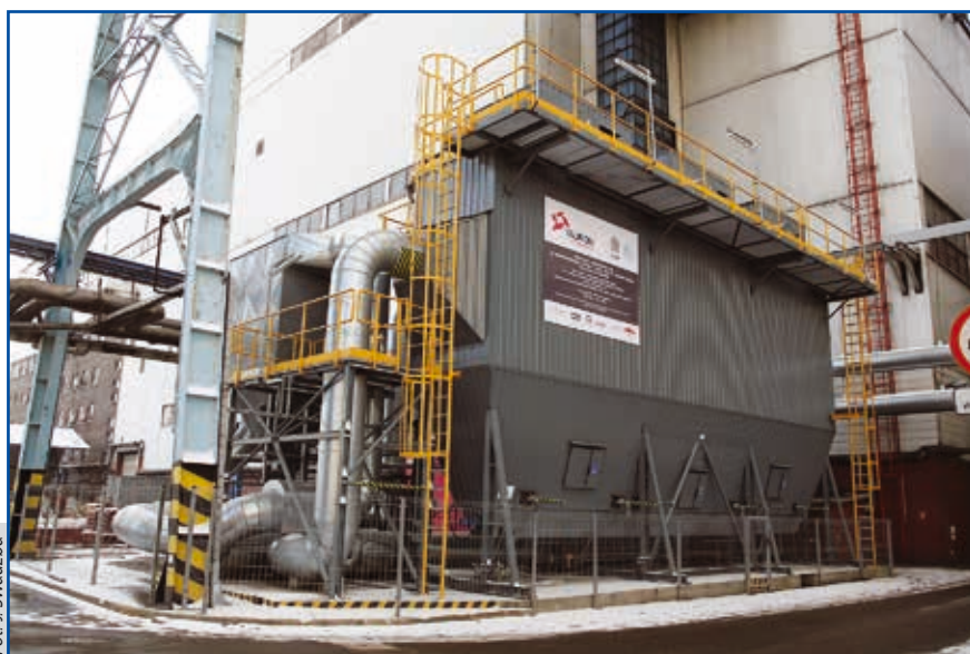
Instalacja demonstracyjna do monitorowania i redukcji emisji rtęci ze spalania węgla w kotłach pyłowych
