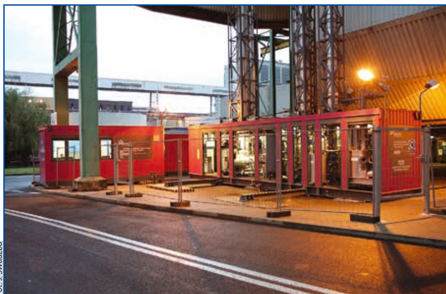
Instalacja pilotowa aminowego usuwania ze spalin CO 2
